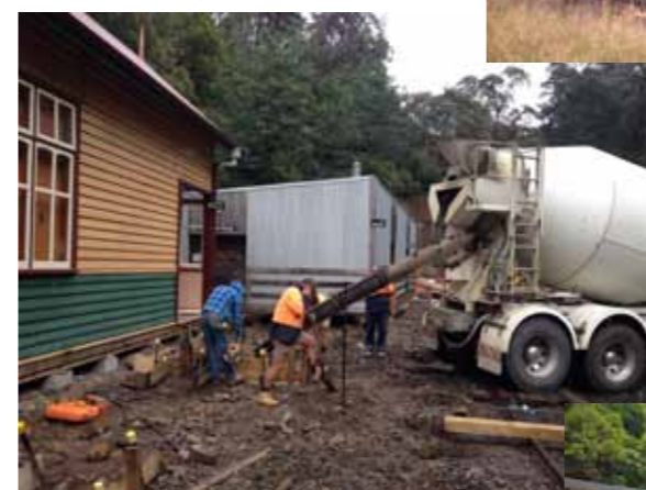
BELOW: Concrete pour of footings for verandah
